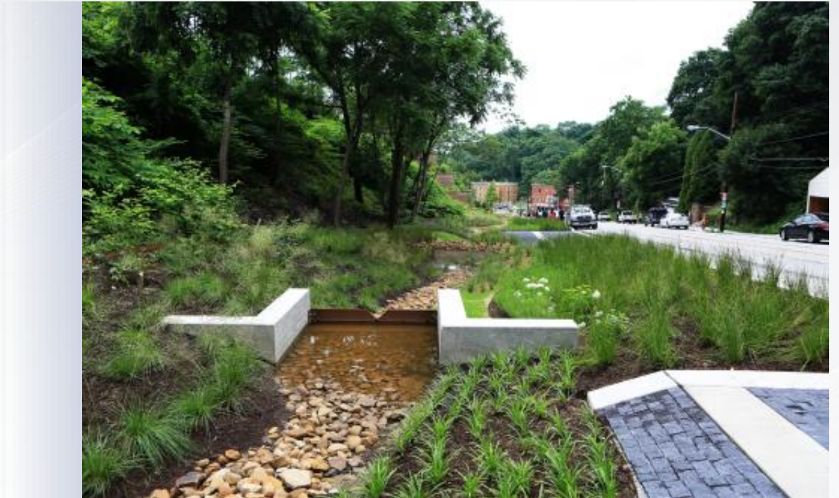
Lassított csapadékvíz-elvezetés, USA, Pittsburgh
